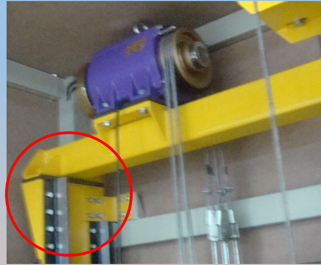
Motor girişinin izole edilmesi
